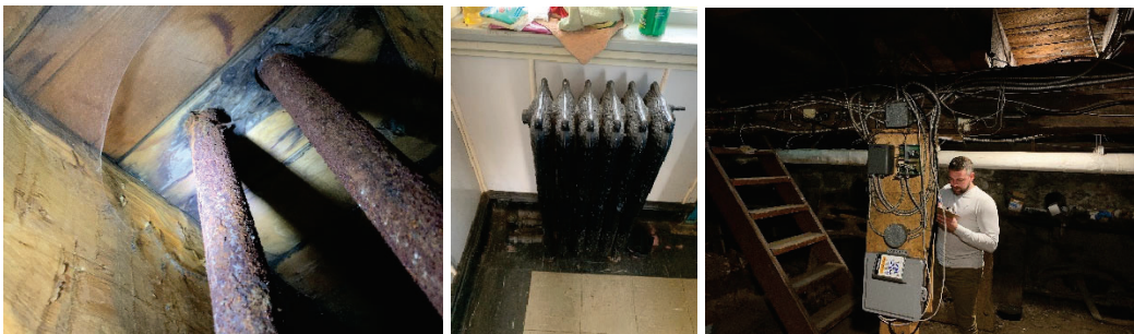
Composantes du chauffage à l'eau chaude
