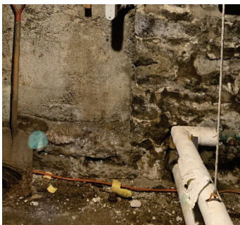
Entrée d'eau existante
